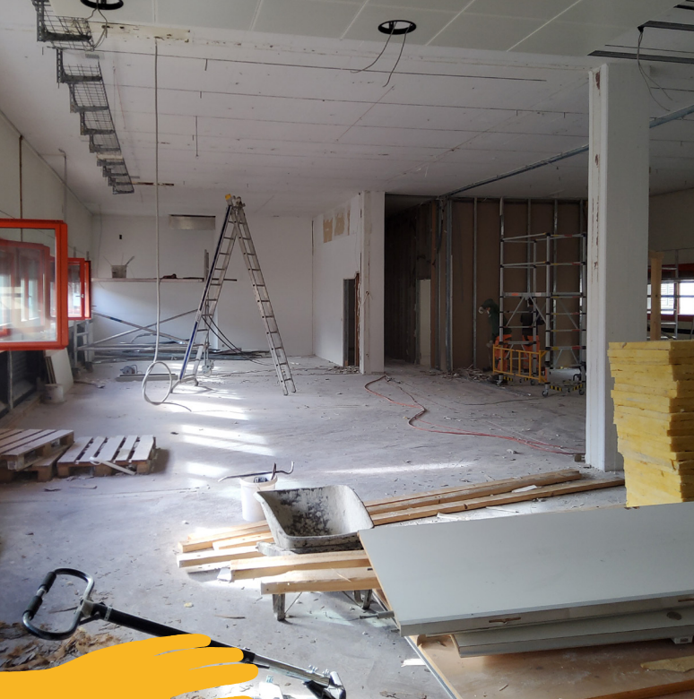
Umbau der neuen Räumlichkeiten der Regionalstelle in Ilanz
